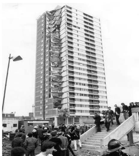
1 pav. Ronan Point progresyvi griūtis [18]
