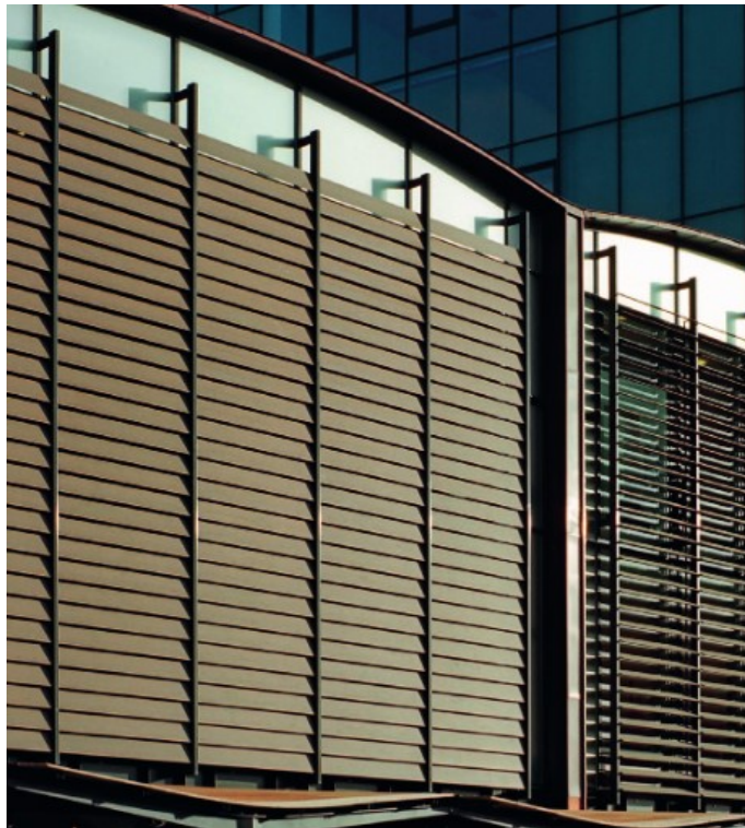
1.3 pav. Ant pastato fasado sumontuota temdymo konstrukcija [4]
