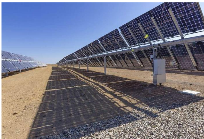
5 pav. Dvipusiai saulės moduliai sumontuoti ant saulę sekančių konstrukcijų[22]
