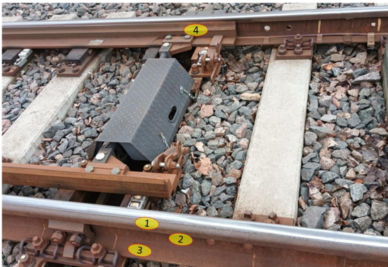
2.2 pav. Temperatūrų matavimo vietos ant rėminio bėgio ir iešmo. 1 – rėminio bėgio galvutė; 2 – rėminio bėgio kakliukas; 3 – rėminio bėgio padas. 4 – iešmo smailė.
