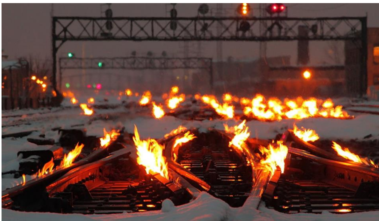
1.9 pav. Geležinkelio iešmų šildymas dujų degikliais atvira liepsna [63]
