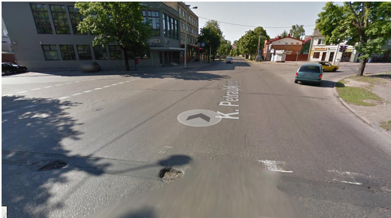
3.1 pav. Reguliuojama sankryža
