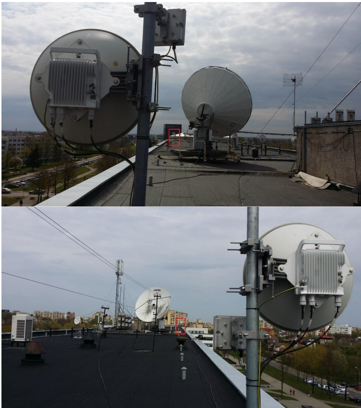
22 pav. Ant KTU elektronikos rūmų stogo įrengta E-juostos diapazono sistema
