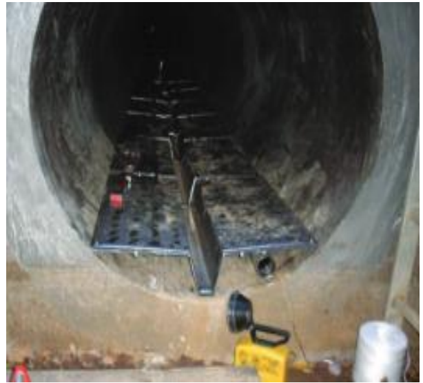
1.6 pav. Nuotekų vamzdyno rekonstrukcija, įterpiant šilumokaičio sistemą [28]
