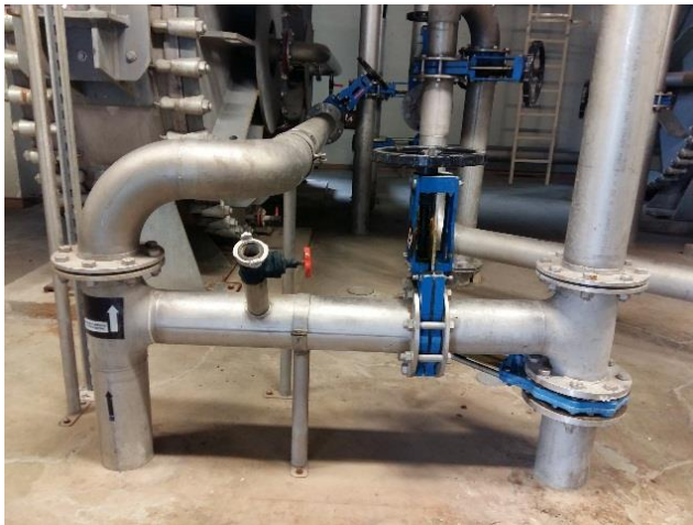
2.1 pav. Dumblo ūkio vamzdynų sistemos dalis Kauno nuotekų valykloje; L – vamzdynų ilgis, d_1 – vidinis skersmuo (150 mm); d_2 – išorinis skersmuo (153 mm)
