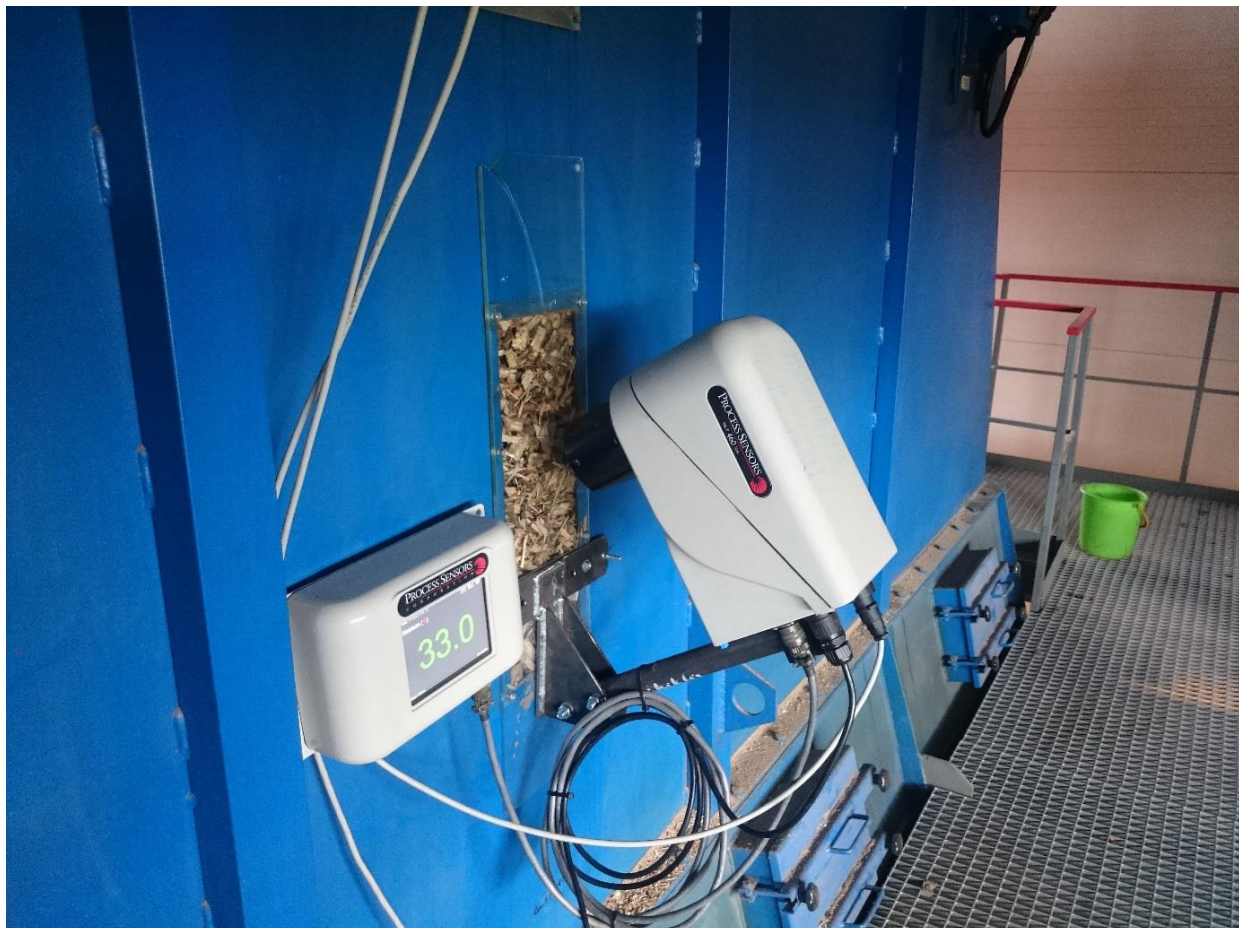
Pav. 3.13 Drėgnomatis sumontuotas katilinėje
