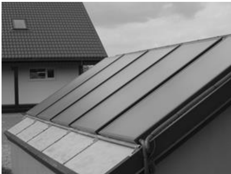
5.28 pav. Saulės kolektorių išdėstymas ant pastato stogo.
