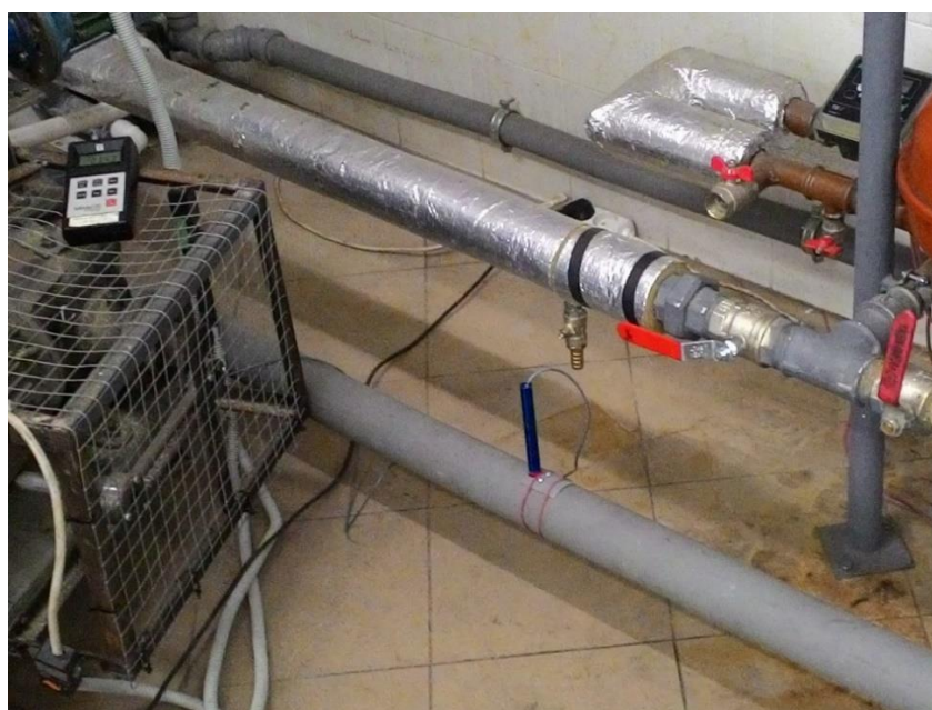
2.5.1 pav. Antrinio oro tiekimo vamzdžio ruožas, per kurį kartu su oru tiekiamos degios dujos.
