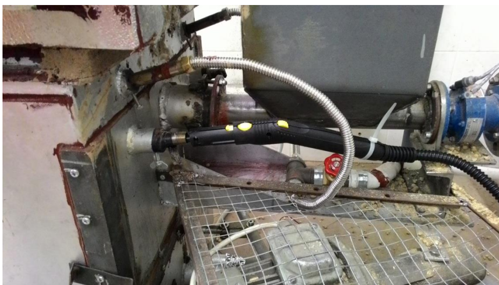
2.4.2 pav. Į antrinio oro padavimo angą įkištas garo generatoriaus antgalis.
