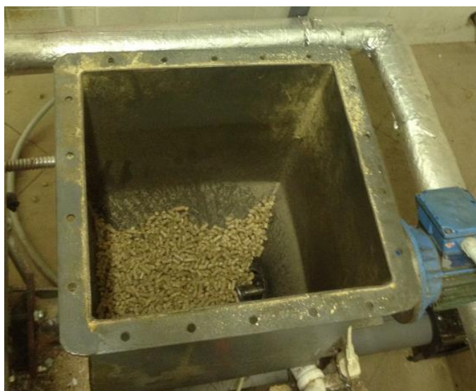
2.1.2 pav. Kuro padavimo bunkeris su šneku.
