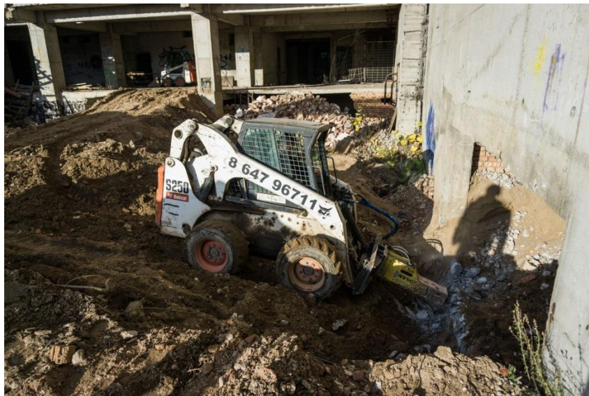
5.4 pav. „Bobcat“ krautuvai vykdo griovimo darbus ( www.statybunaujienos.lt )
