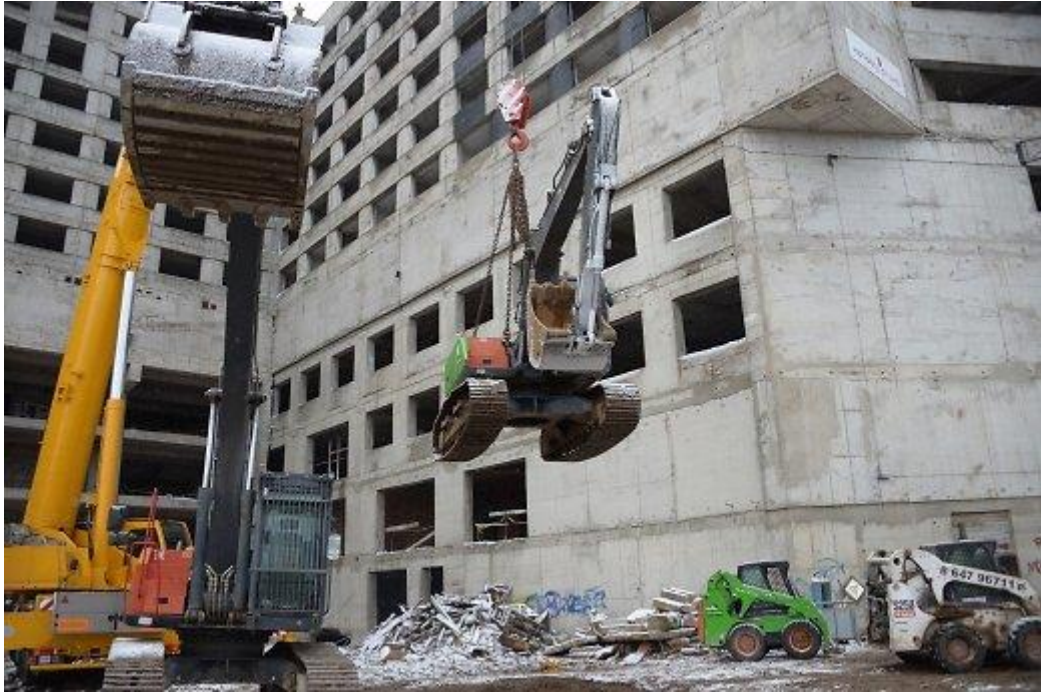
5.5 pav. Ekskavatoriaus kėlimas ant „Respublikos“ stogo ( www.15min.lt )
