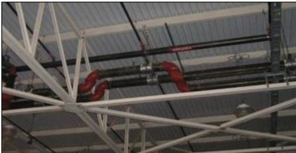
24 pav. Virtualūs statybų dokumentai ir montavimo nuotraukos Pastaba: pateikta remiantis LLC ir Ghafari Associates (NIBS 2006)
