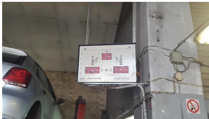
30 pav. Galinės ašies virpesių slopintuvų būklės nustatymas
