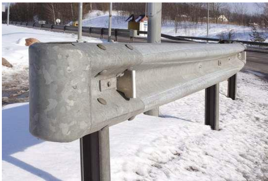
3.4. pav. Apsauginių atitvarų pradžia ir galas virš žemės.
