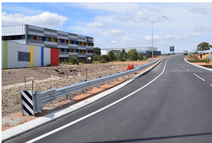
3.6. pav. Smūgio slopintuvus atitvarų gale.
