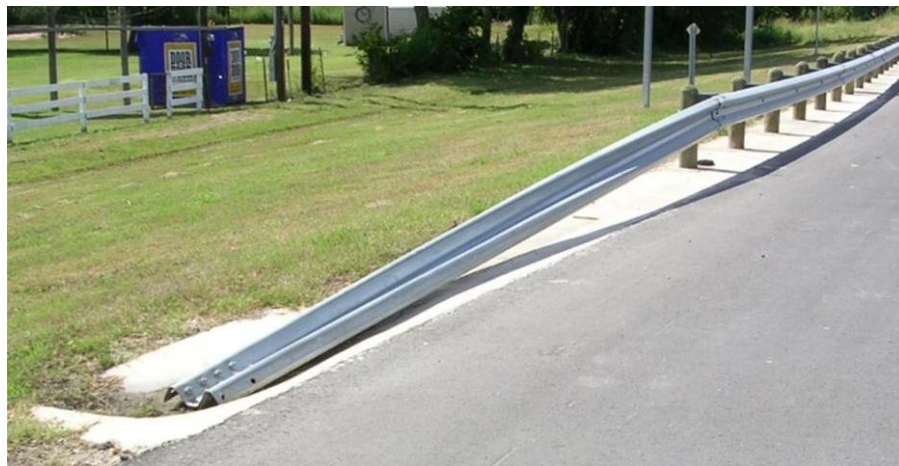
3.3. pav. Apsauginių atitvarų pradžia ir pabaiga pasibaigianti žemėje.
