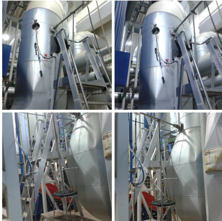
1.5 pav. Dūmų matavimo vietos už katilo ir multiciklono
