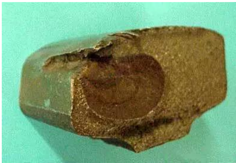
4 pav. Dėl įtempių bėgyje atsiradęs defektas [7]
