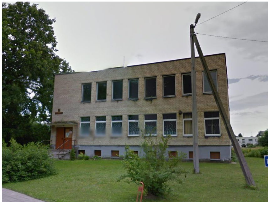
3 pav. Kruonio gimnazijos universalaus daugiafunkcinio skyriaus pastatas prieš rekonstrukciją
