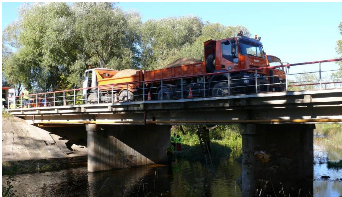
3.4 pav. Tilto per Pyvesą statinio bandymo nuotrauka (bendra apkrovos masė – 80,20 t) [51]
