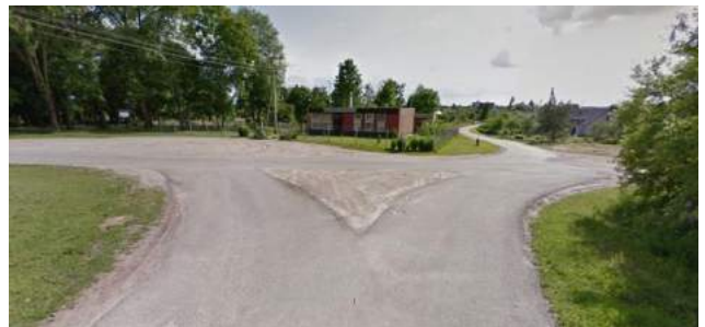
60 pav. Centrinė gyvenvietės dalis (google maps)
