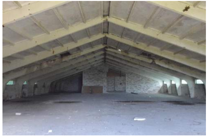
64 pav. Kliuskinės konstrukcinės sistemos fermos vidus
