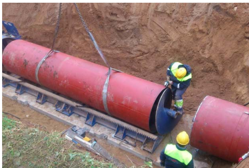
12 pav. Vamzdžių sujungimas [17]
