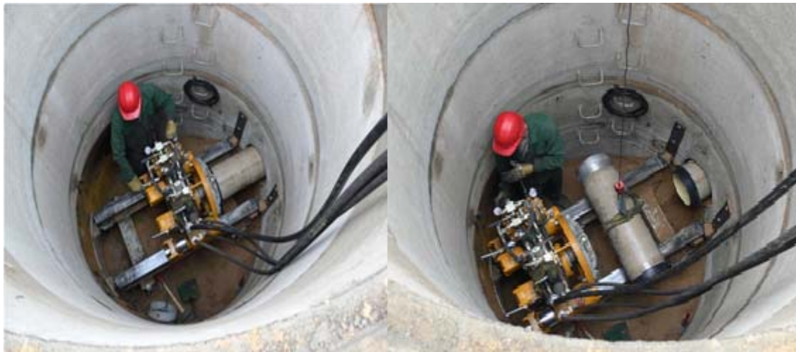
14 pav. Šachtos vaizdas (kairėje: gręžimas, dešinėje: vamzdžio sujungimas) [12]
