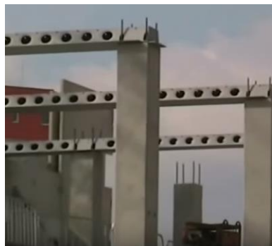
1.10 pav. Sijos tvirtinamos ant kolonos viršaus
