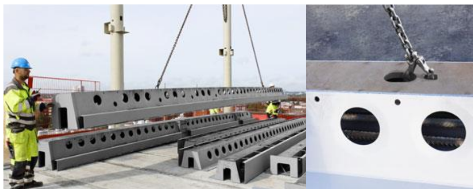
1.16 pav. Kompozicinės sijos karkaso pakėlimas
