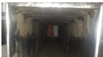
4.29 pav. Sijos viršutinės juostos suvirinimas iš vidaus
