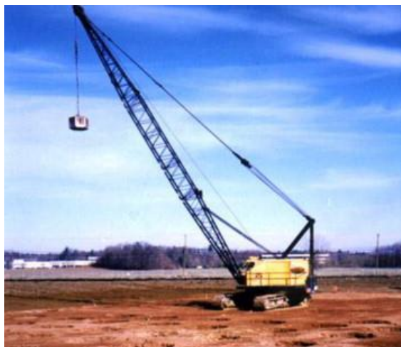
11 pav. Grunto dinaminis tankinimas [22]
