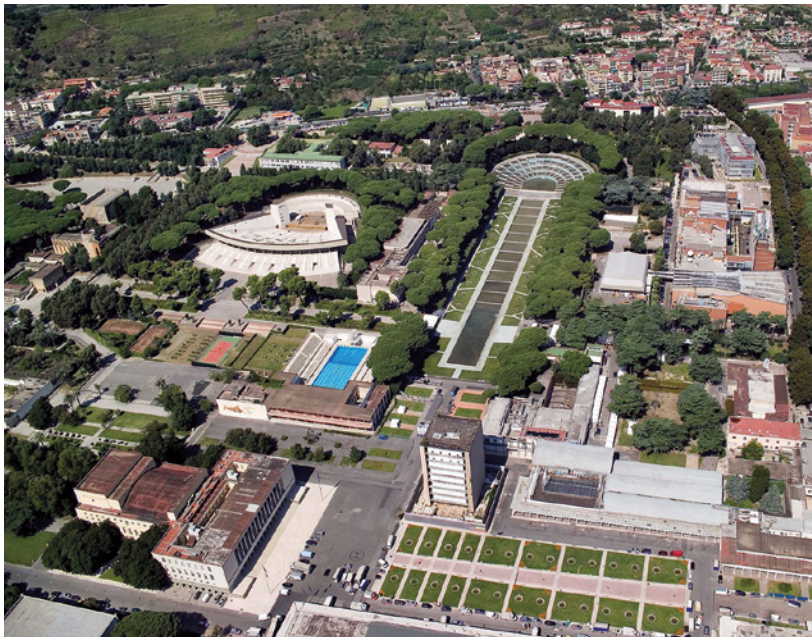
Figure 82 Aerial view of Mostra d'Oltremare. © Paolo de Stefano, 2006.
