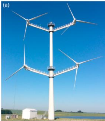
8 pav. Daugiarotorinė vėjo jėgainė [40]
