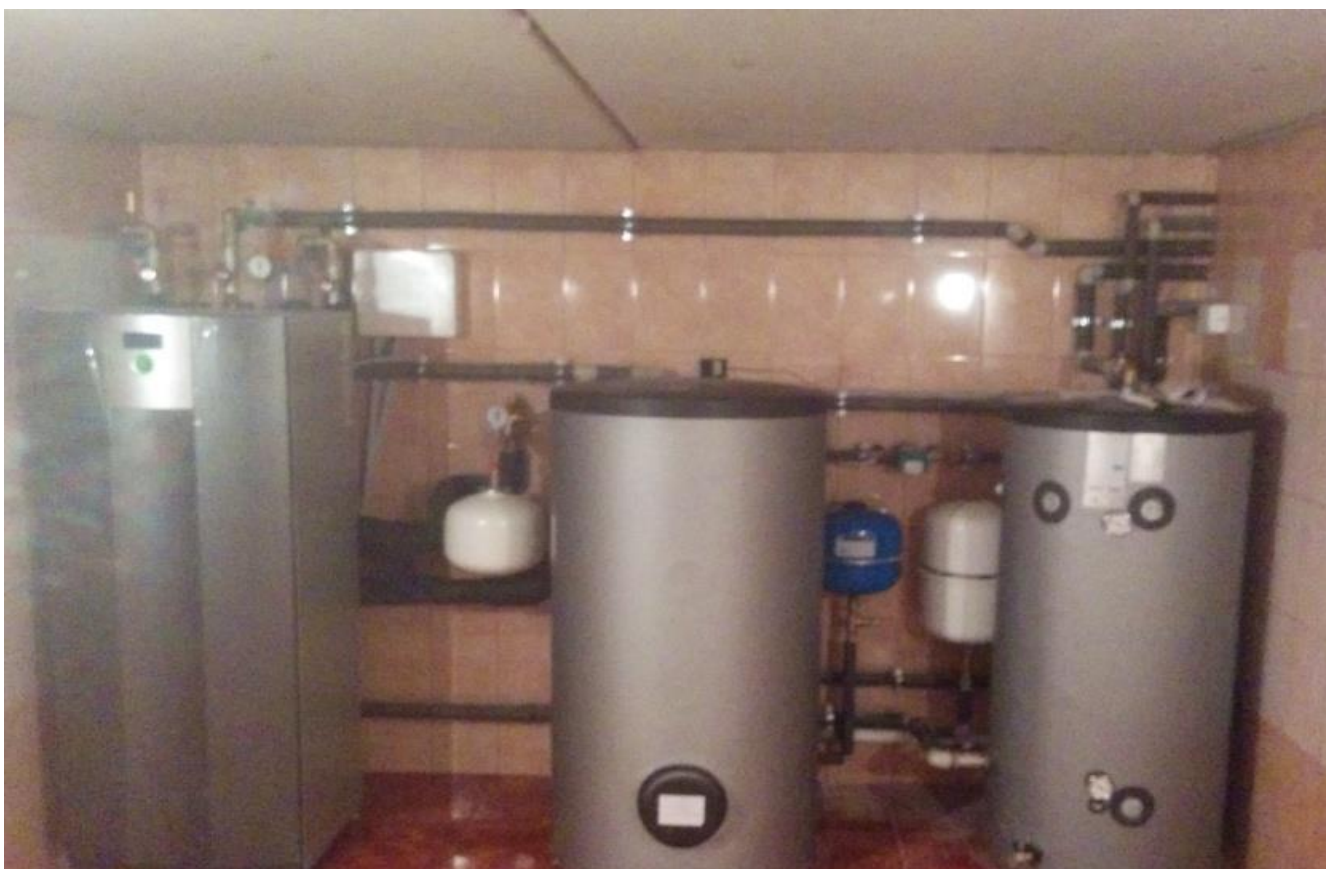
9.6 pav. Hidraulinis šilumos siurblio pajungimas
