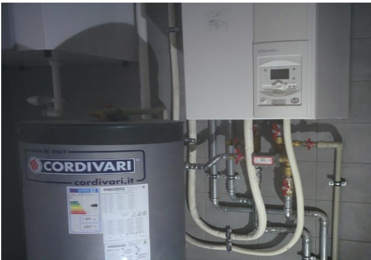
9.2 pav. Hidraulinis šilumos siurblio pajungimas
