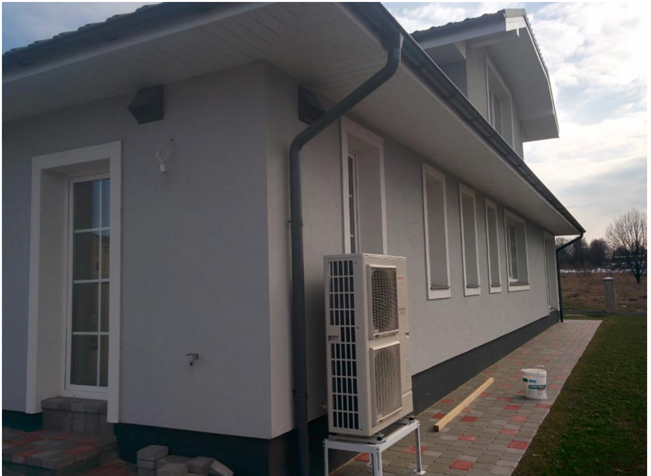
9.1 pav. Pastato vakarinis fasadas
