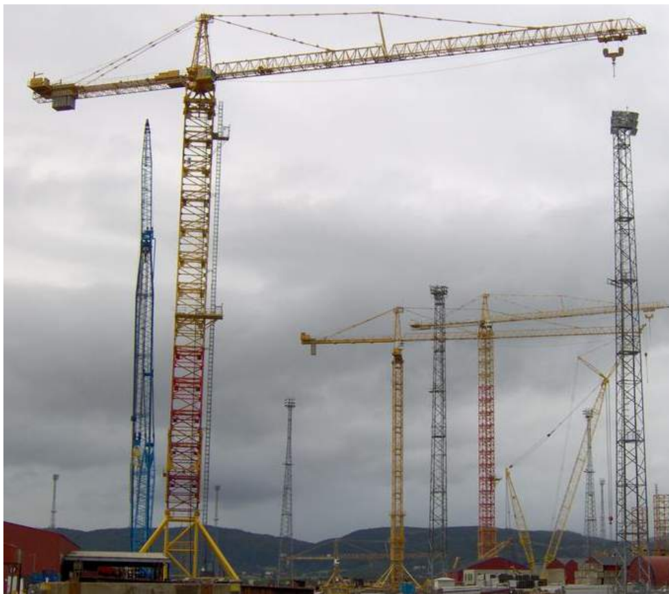
Pav. 4.4. Bokštinis kranas LIEBHERR 3150 HC 70
