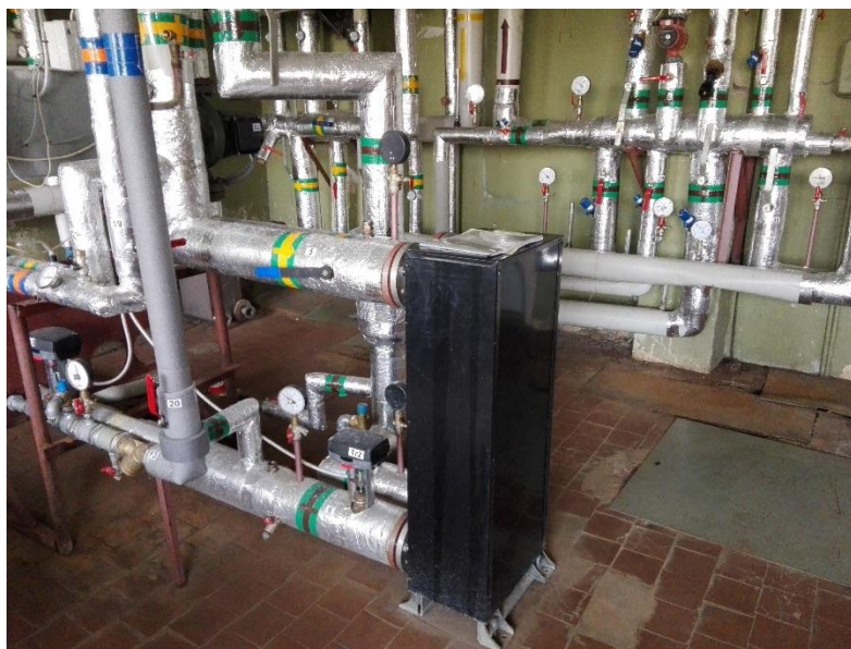
1 Pav. Pastato šilumos punktas
