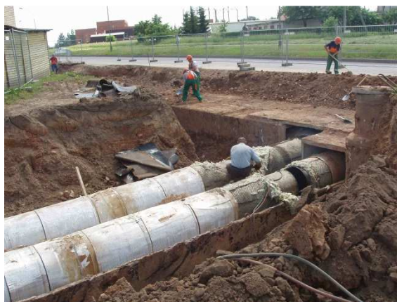
3 Pav. Kanalas iš lovinių elementų
