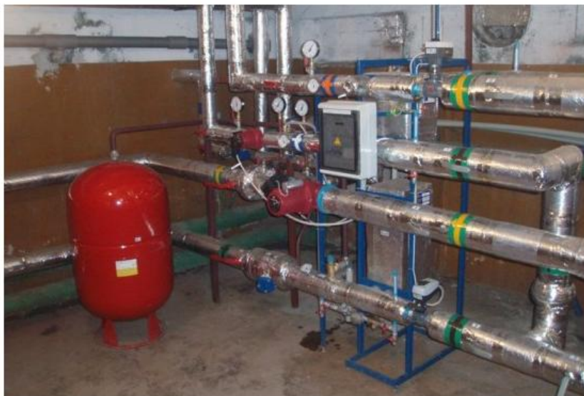
1.3pav. Automatizuotas šilumos punktas
