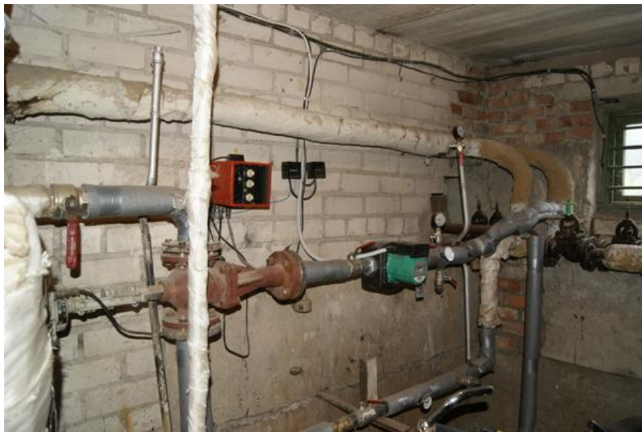
1.2pav. neautomatizuoto šilumos punkto pavidys
