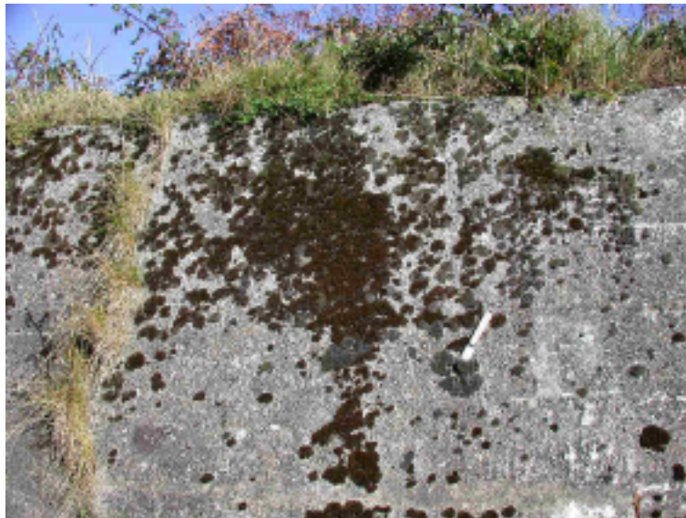
1.13 pav. Kerpės ant betono
