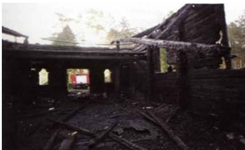
1.1 pav. Vaizdas po gaisro. Statinio medinės konstrukcijos nebuvo impregnuotos antipireniais. [10]
