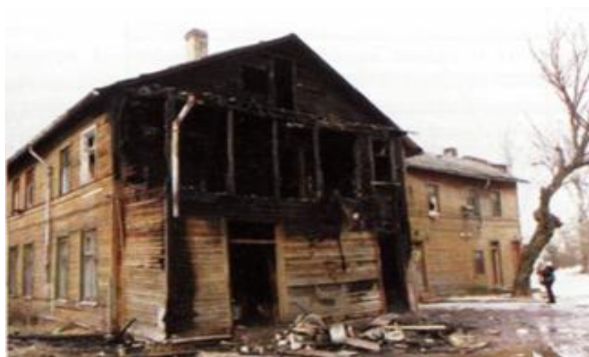
1.2 pav. Nuotraukoje matyti kaip pastatas atrodo po gaisro, statinio konstrukcijos buvo impregnuotos antipireniais. [10]
