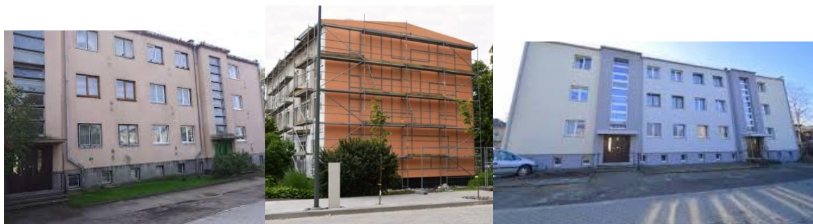
4.2 pav. Oškinių g. 5, Palanga. Iš kairės: nerenovuotas namas, daugiabutis, renovacijos metu atnaujintas (modernizuotas) pastatas
