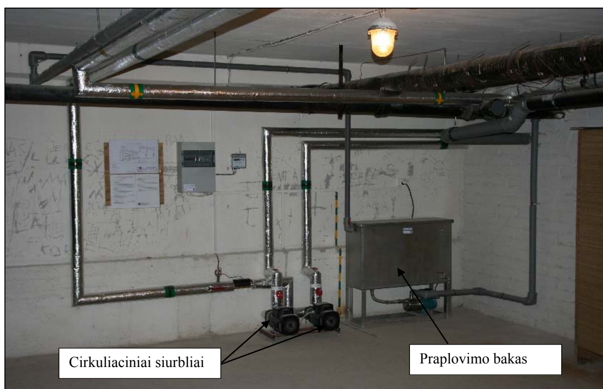
Pav. 6 Sumontuoti cirkuliaciniai siurbiai ir praplovimo bakas
