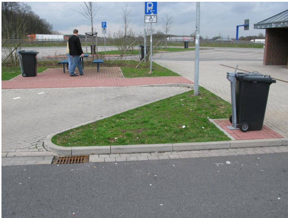
1 pav. Betoninių trinkelių panaudojimas automobilių stovėjimo aikštelėje
