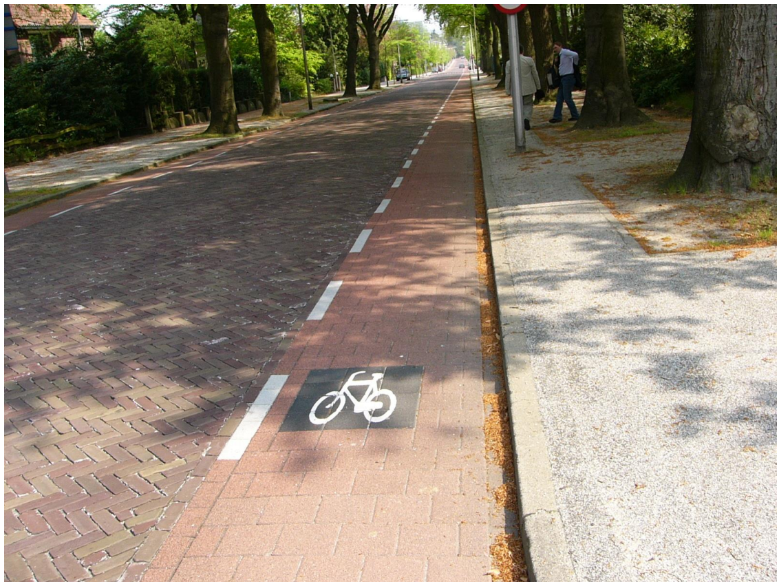
6 pav. Betoninių trinkelų panaudojimas eismo juostų atskyrimui
