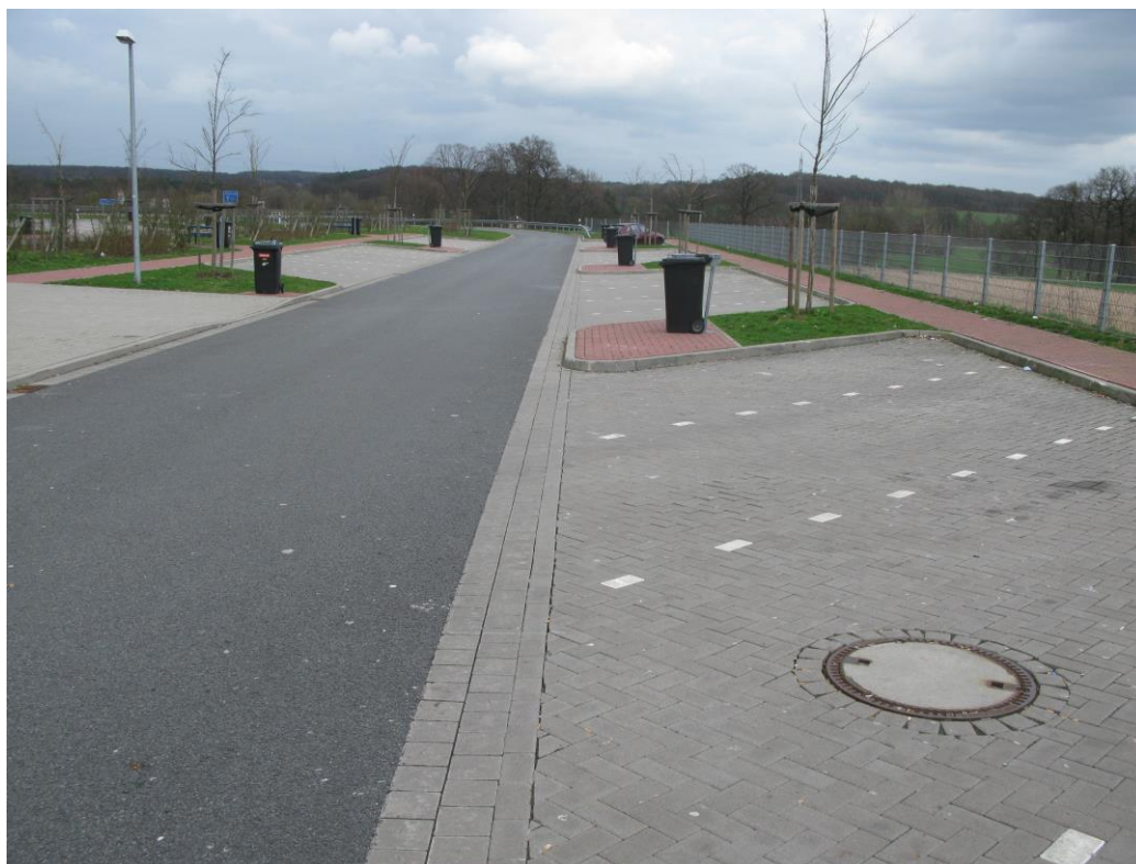
2 pav. Betoninių trinkelių panaudojimas automobilių stovėjimo aikštelėje
