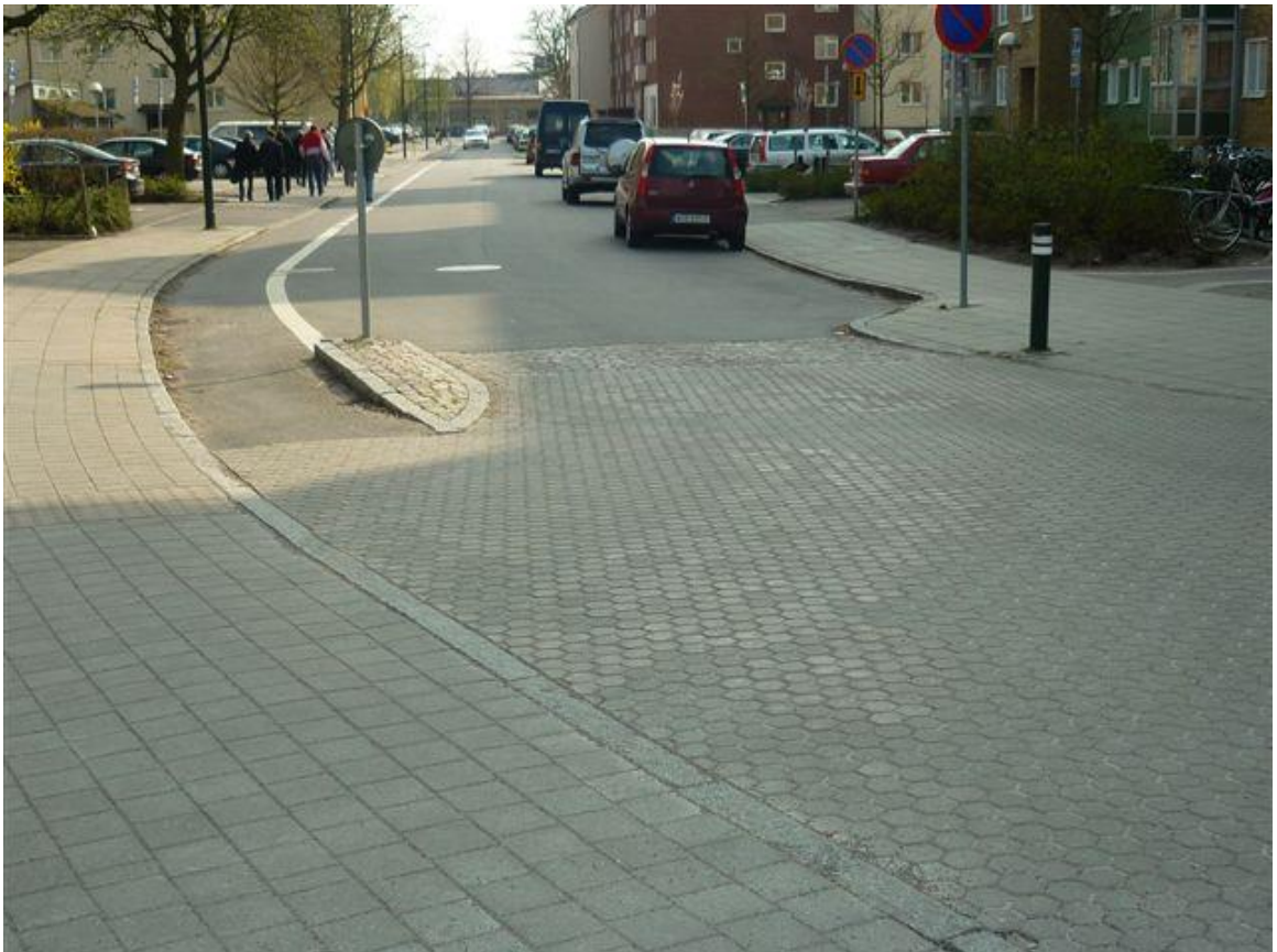
4 pav. Betoninių trinkelų panaudojimas gatvės susiaurinimui
