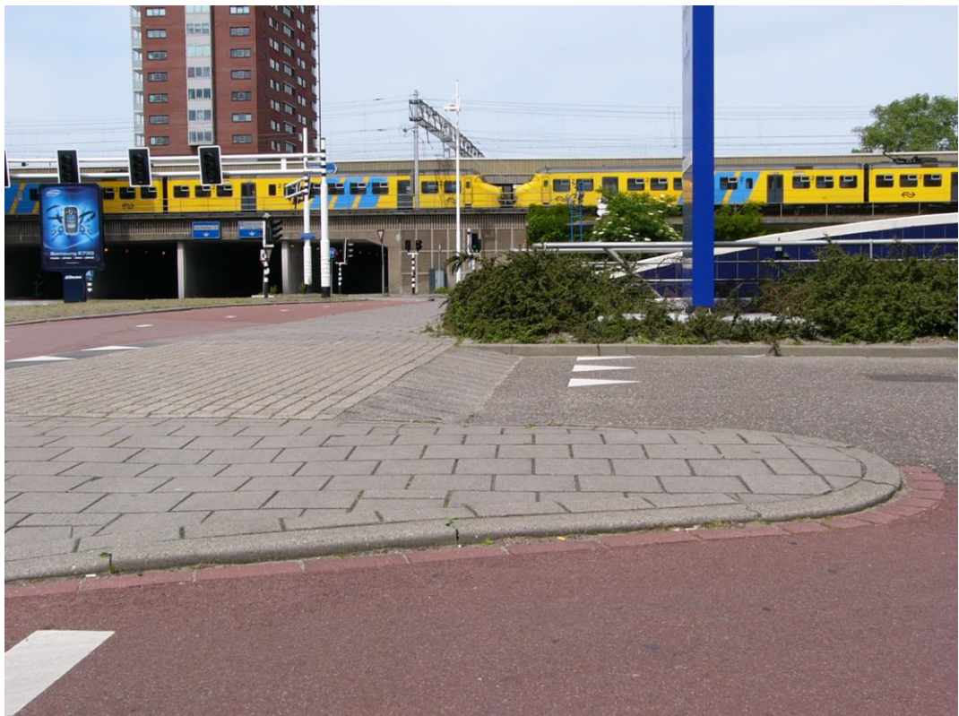
5 pav. Betoninių trinkelų panaudojimas greičio mažinimo kalneliui
