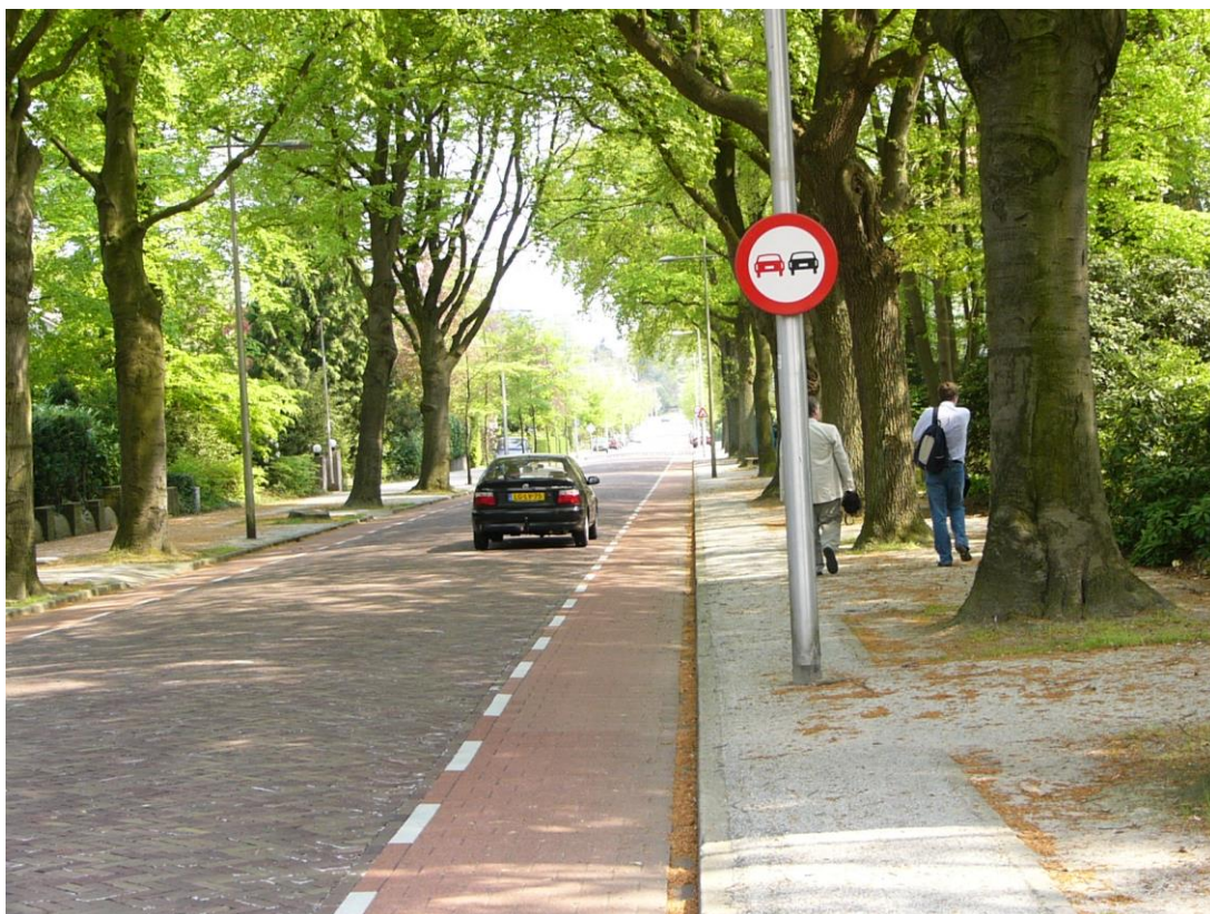
7 pav. Betoninių trinkelų panaudojimas eismo juostų atskyrimui
