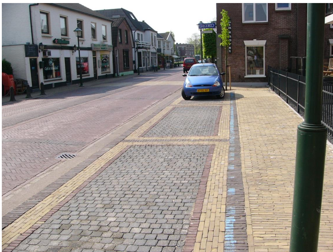
9 pav. Betoninių trinkelų panaudojimas automobilių stovėjimui
