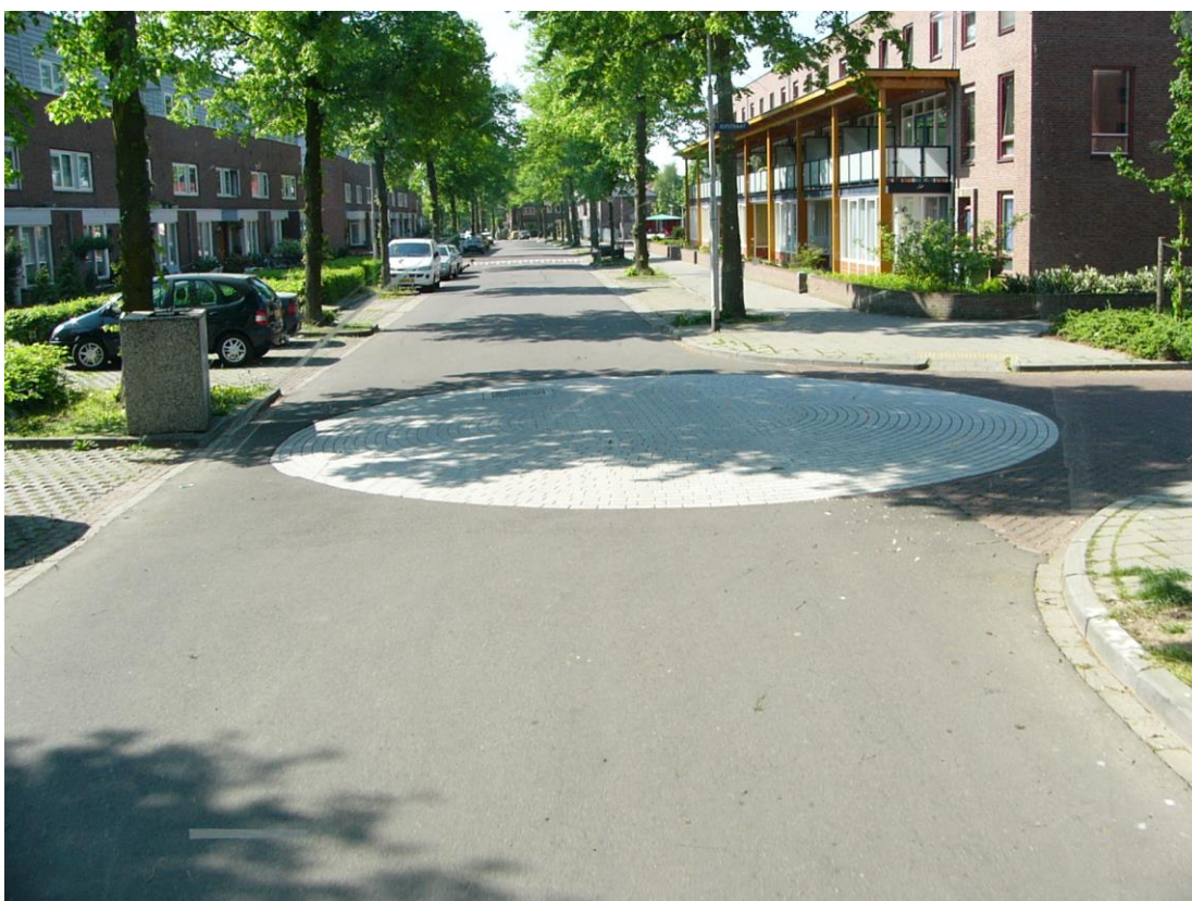
10 pav. Betoninių trinkelų panaudojimas žiedinės sankryžos įrengimui
