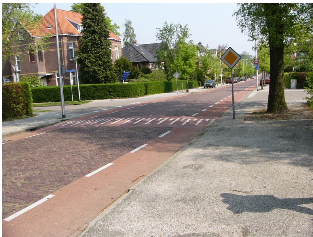
8 pav. Betoninių trinkelų panaudojimas gyvenamajame kvartale
