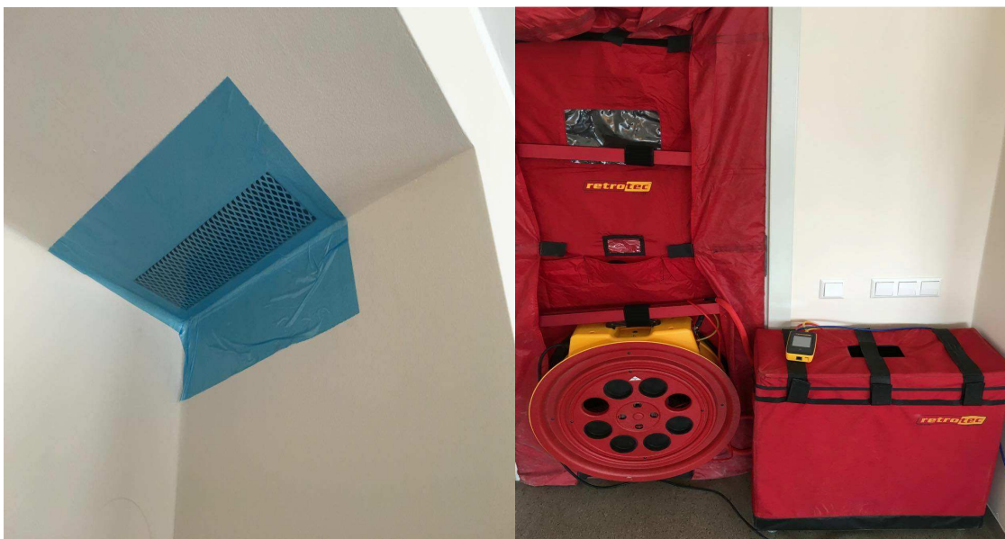
4 pav. Užsandarinami natūralaus vėdinimo kanalai (kairėje), įstatomos „pučiamos durys“ (dešinėje)
