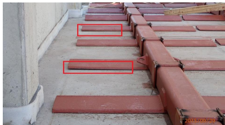
5.5 pav. Žertuvų užsiritimas
