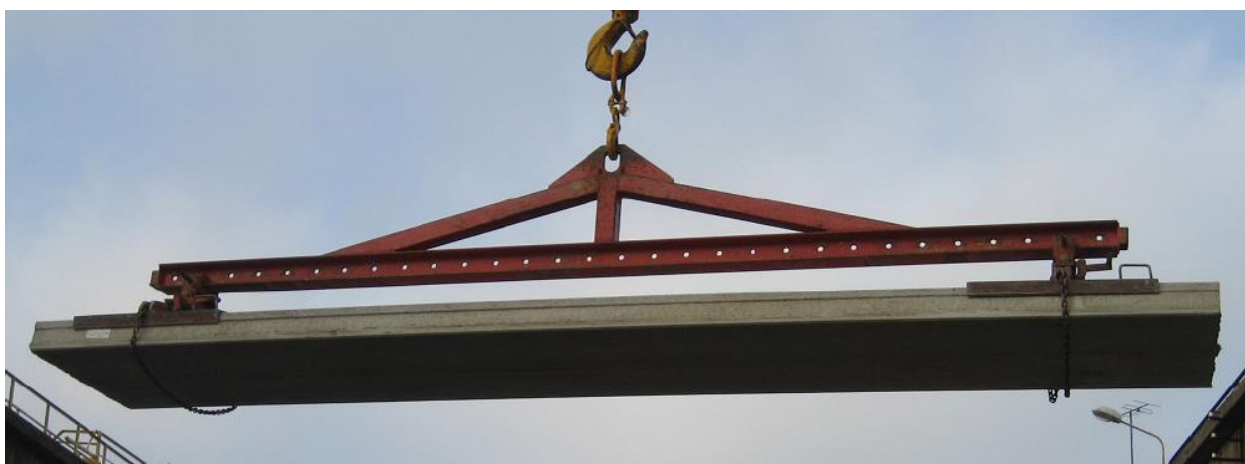
5.3.2. pav. Perdangos plokštės kėlimas
