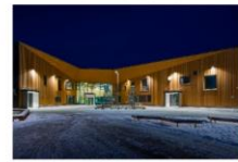
30 Hiukkavaaran monitoimitalo Finland | 2017 | LEED | Gold
