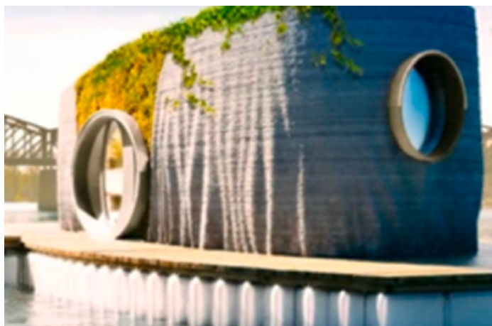
5 pav. 3D spausdintuvu spausdintas plūduriuojantis pastatas Čekijoje [7]
