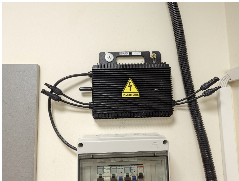
20 pav. Hoymiles mikroinverteris HMS-800W-2T
