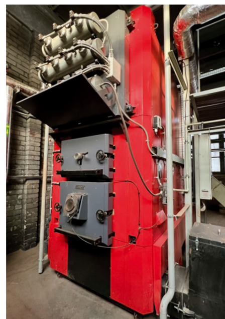
UAB „Kalvis“ katilas Svėdasų katilinėje
