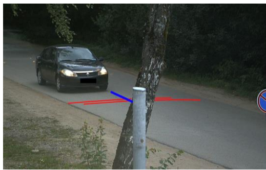
19 pav. Kelyje įdiegta sistema. Mėlynai pažymėtas – jutiklių blokas, o raudonai – grioveliai, atsiradę po sistemos integravimo kelio dangoje
