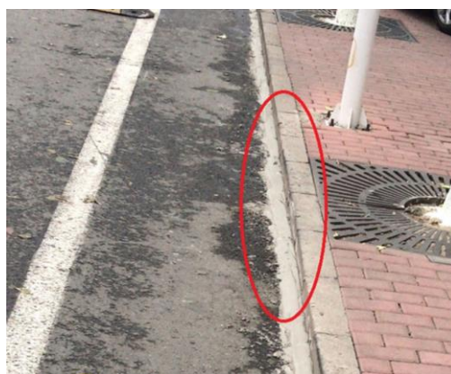
7 pav. Kelio krašte įdiegtas šviesolaidis [10]
