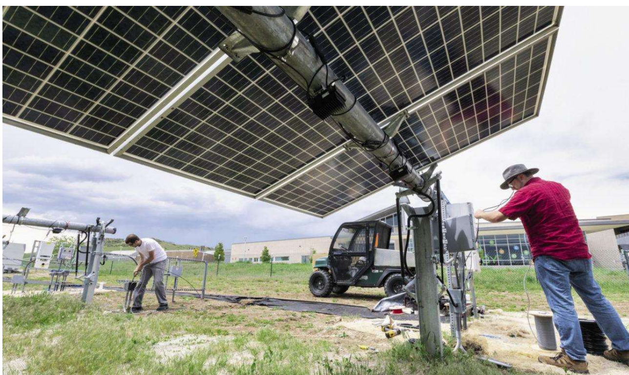
1.5 pav. Dvipusiai FV moduliai, sumontuoti su sekimo sistema [15]
