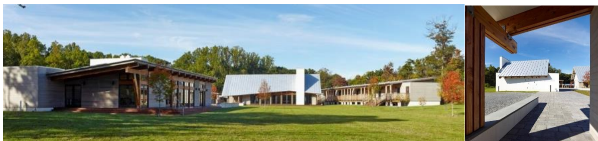
13 pav. Calcagnini rekolekčių centras, kairėje – rytinis kiemas, dešinėje – koplyčia ( Calcagnini Contemplative Center. 2020 )
