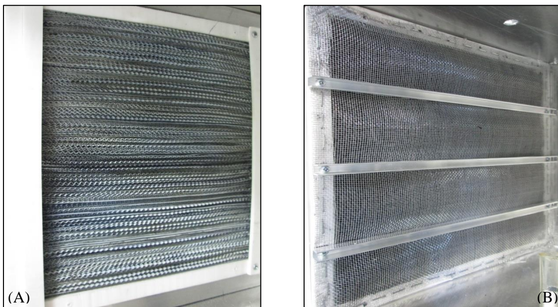
2.2 pav. \text{TiO}_2 katalizatoriaus etapas (A) ir sorbcijos aktyvuota anglimi etapas (B)
