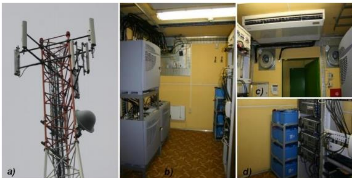
19 pav. BS pagrindinės sudedamosios dalys a) Antenos bokšte, b) BS vidinis modulis, c) kondicionavimo įranga, d) nepertraukiamo maitinimo šaltinis (akumuliatoriai)
