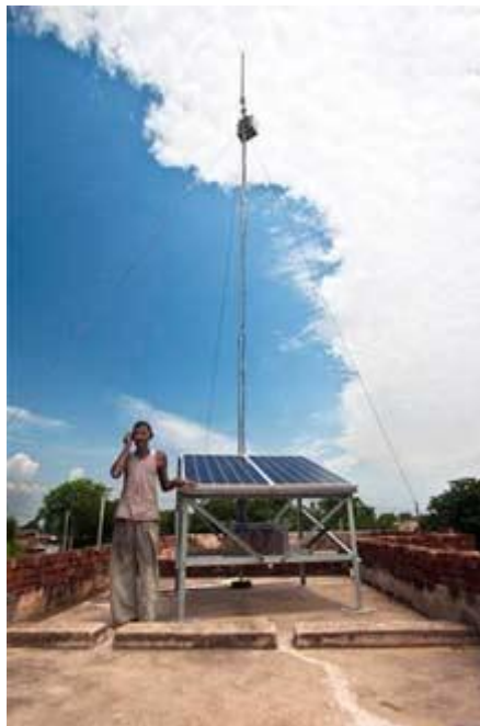
16 pav. Sistema aprūpinanti BS energija Šaltinis: Ike D.U., Adoghe A.U., Abdulkareem A. (2014)
