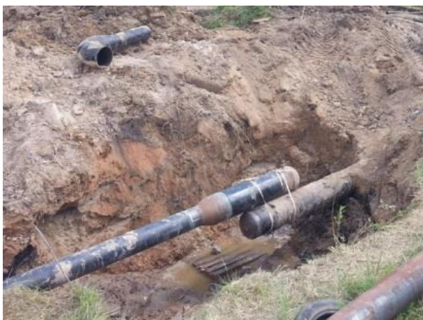
1.5 pav. Panevėžio dujų skirstymo stoties dujotiekis su užvirintomis aklėmis
