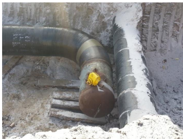
1.4 pav. Kiemėnų dujų apskaitos stoties dujotiekis su užvirintomis aklėmis
