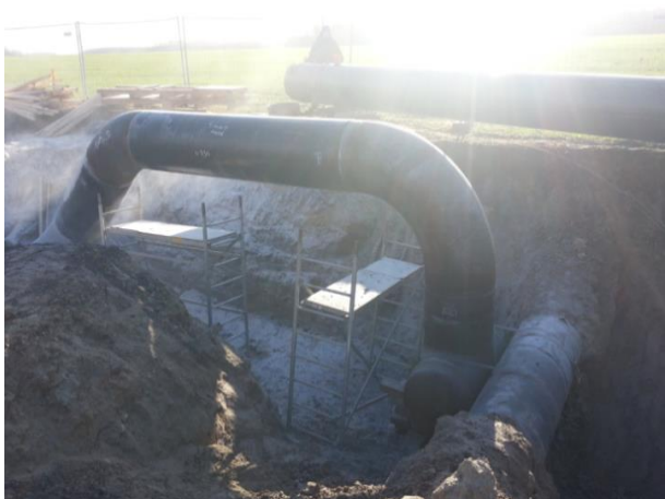
1.4 pav. Kiemėnų dujų apskaitos stoties dujotiekis su užvirintomis aklėmis
