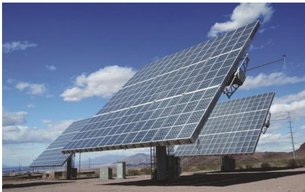
15 pav. Koncentruoti fotoelektriniai moduliai su Saulės sekimo sistemomis [30]
