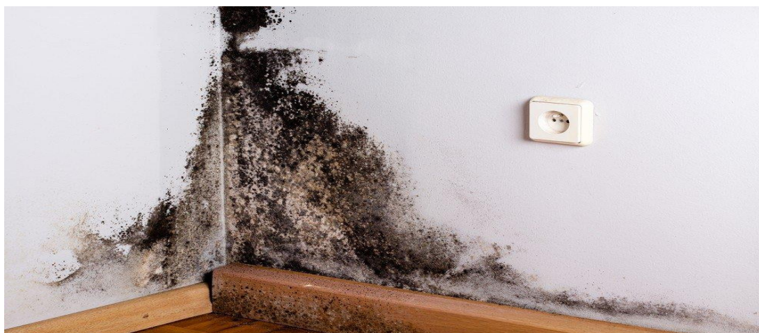
1.1 pav. Pelėsio apimtas kampas drėgnose patalpose
